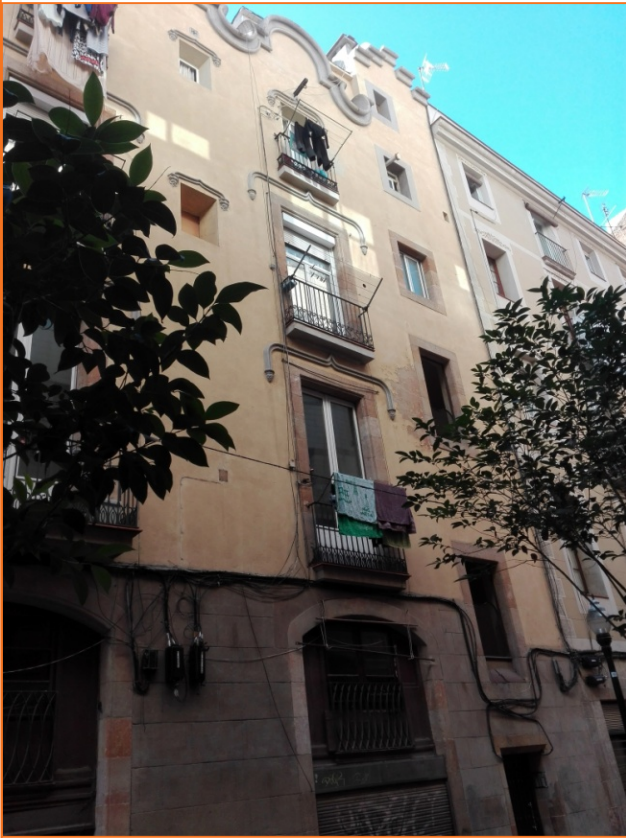
Foto 1. Vista exterior de l'edifici on s'ha realitzat la intervenció.
